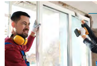
Montage pro- fessionnel
